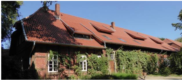
Foto: Dachsanierung historischer Bausubstanz
