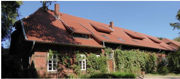
Foto: Dachsanierung historischer Bausubstanz
