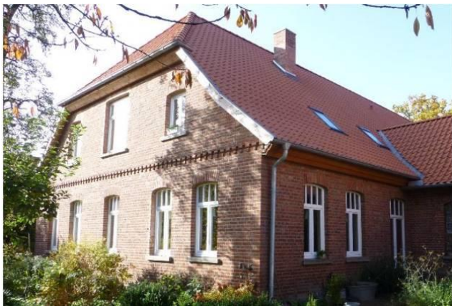
Foto: Umfassend saniertes Gebäude (Dachsanierung, Erneuerung der Fenster, Erneuerung der Steinverfugung)
