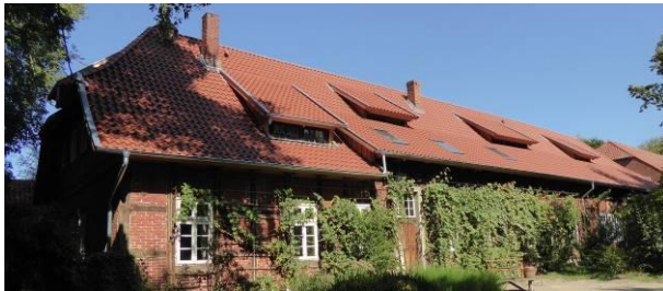
Foto: Dachsanierung historischer Bausubstanz
