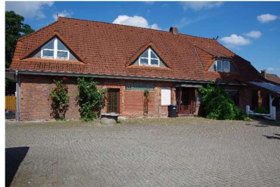
Fassade und Gauben
