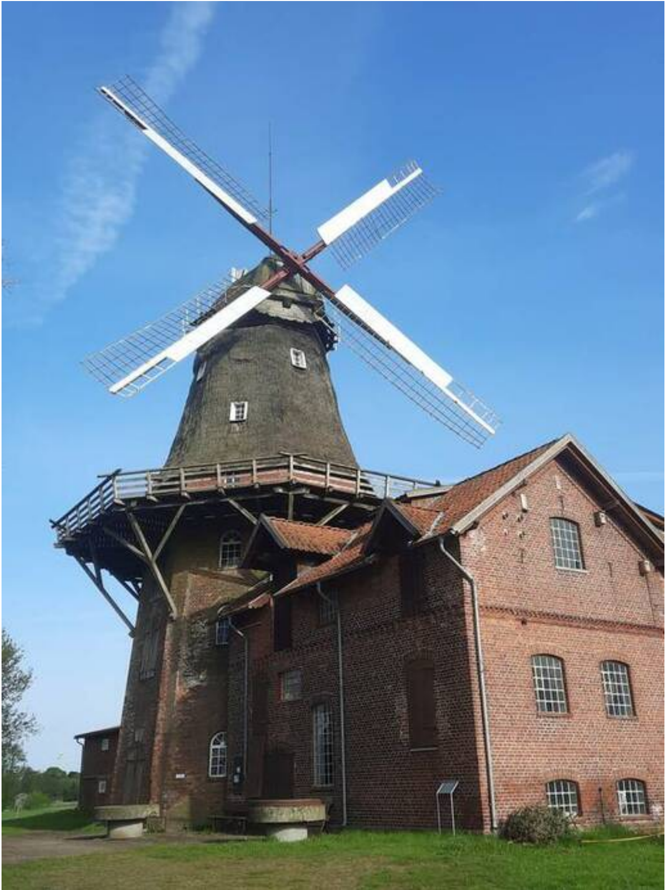
Die Sanierung des Mühlenturms in Brockel und die Erneuerung der Flügel ist ein Projekt, das sich in der Dorfgregion Wiedau-Walsede in der Umsetzung befindet. Foto: kreib
