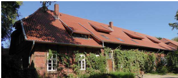
Foto: Dachsanierung historischer Bausubstanz
